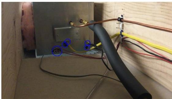
Continuez avec l'alimentation primaire, la commande 24v vers le groupe de condensation, la connexion du contrôleur d'interface à distance et la vidange. (voir pages 36, 37 et 38 pour des instructions supplémentaires). Si vous avez commandé le système de plafond avec un humidificateur autonome en option, l'humidificateur devra également être connecté à l'unité au cours de cette étape.
