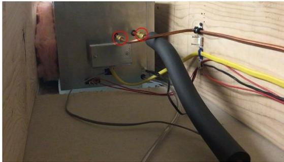
Une fois que le ventilo-convecteur est en place, connectez les équipements à l'unité. Commencez par les conduites de frigorigène. L'unité de Wine Guardian est livrée complète avec des raccords de tuyauterie Swagelok sur la conduite d'aspiration et de liquide. Suivez les instructions de raccordement du fabricant à partir de la page 35 pour une fixation correcte.
