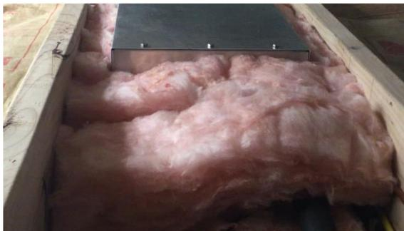
Une fois que tous les équipements sont connectés à l'unité, remplissez les vides ou les trous avec de l'isolant. La mousse à vaporiser à cellules fermées est une méthode
