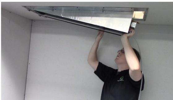
Ce système de verrouillage fonctionne comme une troisième main et vous permet de faire pivoter le ventilo-convecteur en position. Faites pivoter le châssis du ventilo-convecteur vers le haut de manière à ce que les zones
