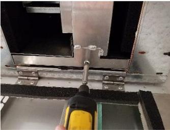
3. Desserrez et retirez la vis de fixation du bac de récupération des condensats à l'extrémité articulée de l'unité. Mettez de côté pour réinstaller une fois que le drain a été nettoyé.
