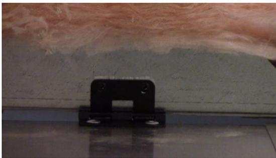
Maintenant que nous avons installé le support de montage, nous pouvons installer le ventilo-convecteur. La première étape de l'installation du ventilo-convecteur consiste à aligner l'extrémité de verrouillage avec l'extrémité de crochet du support de montage. Soulevez le ventilo convecteur sur le support de montage de manière à ce que l'extrémité de verrouillage du ventilo-convecteur repose sur son crochet d'accouplement.
