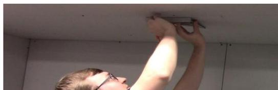
Une fois le plafond isolé et le placoplâtre ou le matériau du plafond installé, marquez et découpez clairement l'ouverture dans le plafond où l'unité sera installée. L'ouverture de la découpe ne doit pas être plus grande que la suivante :
