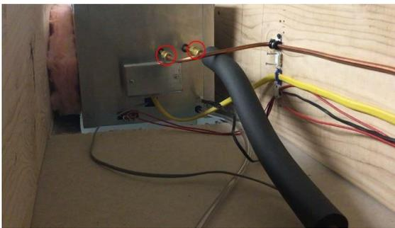
Sobald der Ventilorkonvektor installiert ist, schließen Sie die Versorgungseinrichtungen an das Gerät an. Beginnen Sie mit der Kältemittelleitung. Die Wine Guardian-Einheit wird komplett mit Swagelok Rohrleitungsanschlüssen an der Saugleitung und der Flüssigkeitsleitung geliefert. Für eine ordnungsgemäße Befestigung, befolgen Sie die Anschlussanweisungen des Herstellers ab Seite 35.
