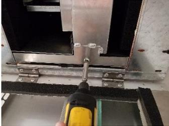
3. Lösen und entfernen Sie die Befestigungsschraube der Kondensatablaufwanne am schwenkbaren Ende des Geräts. Nach dem Reinigen des Abflusses wieder einbauen.
