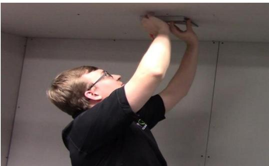
Nachdem die Decke gedämmt und die Felsplatte oder das Deckenmaterial installiert wurde, ist die Öffnung in der Decke, in der das Gerät installiert werden soll, deutlich zu markieren und auszuschneiden. Die Öffnung des Ausschnitts sollte nicht größer als die folgende sein:
