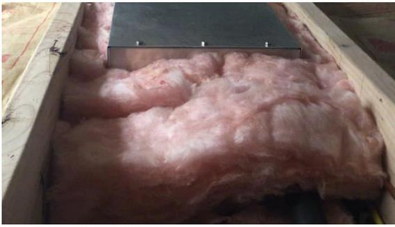
Nachdem alle Versorgungsleitungen an das Gerät angeschlossen sind, füllen Sie eventuelle Hohlräume oder Löcher mit einer Isolierung aus. Geschlossenporiger Schaumstoffspray ist eine gebräuchliche Isoliermethode, die hervorragende Dampfsperre- und Isolierwirkungen bietet.
