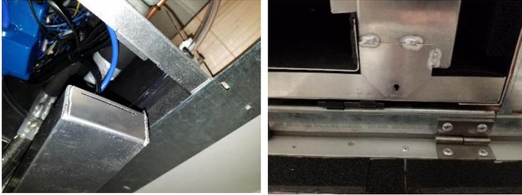
9. Installieren Sie die Kondensatwanne wieder, indem Sie das Aufnahmerohr wieder anbringen und das Steuerkabel wieder anschließen.
