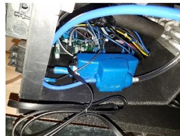
5. Ziehen Sie den Schlauch aus dem Anschluss an der Halterung und ziehen Sie das Steuerkabel wie gezeigt von der Seite der Pumpe ab. Die Pfanne sollte jetzt frei von der Deckeneinheit sein.
