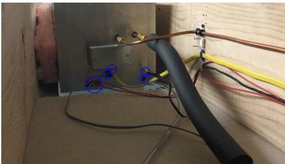
Fahren Sie mit der Hauptstromversorgung, der 24-V-Steuerung des Verdichters, dem Anschluss der Schnittstellenfernsteuerung und dem Abfluss fort. (siehe Seite 36, 37 und 38 für zusätzliche Anweisungen). Wenn Sie das Deckensystem mit einem optionalen freistehenden Befeuchter bestellt haben, muss der Befeuchter während dieses Schrittes ebenfalls an das Gerät angeschlossen werden.
