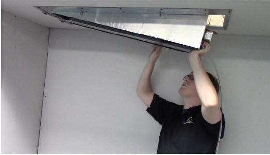
Dieses Verriegelungssystem funktioniert wie eine dritte Hand und ermöglicht es Ihnen, den Ventilorkonvektor nach oben in Position zu schwenken. Schwenken Sie das Ventilorkonvektor-Gehäuse nach oben, so dass die Schlitzbereiche an beiden langen Enden der Einheit über die Gewindeanschlüsse am Befestigungsflansch gleiten
