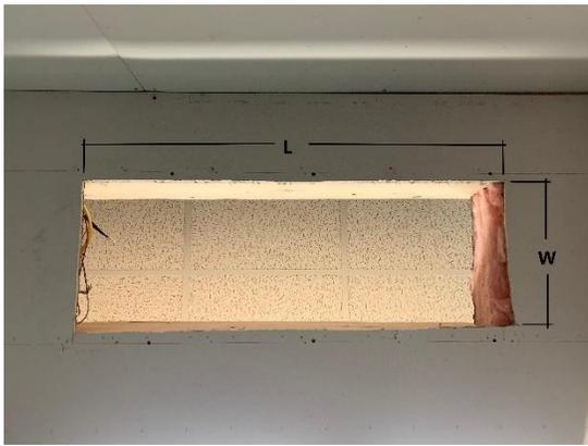
Stellen Sie sicher, dass Sie die Lage der Balken berücksichtigt haben, bevor Sie das Loch für die Einheit schneiden. Bei alten Bausubstanzen sind alle Vorkehrungen zu treffen, um sicherzustellen, dass der Montagebereich vor dem Schneiden der Decke frei ist und keine Versorgungsleitungen vorhanden sind.
