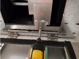
3. Afloje y retire el tornillo de retención de la bandeja colectora de condensación en el extremo con bisagras de la unidad. Guárdelo para volver a instalarlo una vez que se haya limpiado el drenaje.
