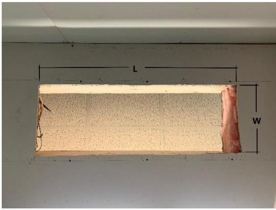
Asegúrese de tener en cuenta la ubicación de las vigas antes de hacer el orificio para la unidad. En construcciones antiguas, tome todas las precauciones para asegurarse de que el área de montaje esté libre y no tenga conexiones de servicios antes de cortar el techo.
