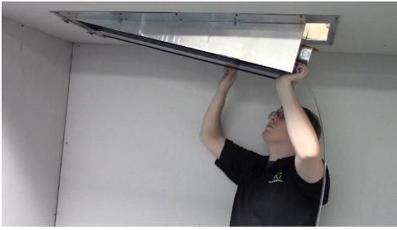
Este sistema de pestillo funciona como un tercer soporte y le permite girar el ventilador a su posición. Mueva el bastidor del ventilador hacia arriba para colocarlo en su lugar de modo que las áreas ranuradas de ambos extremos de la unidad se deslicen sobre las uniones roscadas de la brida de montaje.
