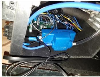
5. Retire el tubo de su conexión en la captación y desconecte el cable de control del lateral de la bomba tal como se muestra. La bandeja ahora debería poder retirarse de la unidad de techo.
