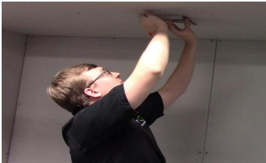
Cuando se haya aislado el techo y se haya instalado el panel de yeso o el material del techo, marque correctamente y corte la abertura en el techo donde se instalará la unidad. La abertura no debe ser más grande que las siguientes medidas:
