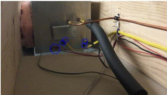
Continúe con el cable de alimentación principal, el control de 24 V a la unidad condensadora, la conexión del controlador de interfaz remoto y el drenaje. (Consulte las páginas 36, 37 y 38 para obtener más instrucciones). Si solicitó el sistema de techo con un humidificador independiente opcional, el humidificador también deberá conectarse a la unidad durante este paso.
