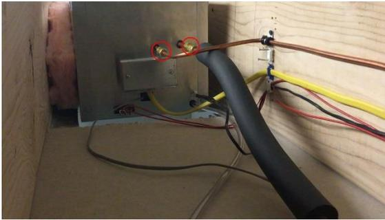
Una vez que el ventilador esté en su lugar, conecte los servicios a la unidad. Comience con la tubería de refrigerante. La unidad Wine Guardian se envía completa con conexiones de tubería Swagelok en la línea de succión y de líquido. Siga las instrucciones de conexión del fabricante que comienzan en la página 35 para una instalación correcta.
