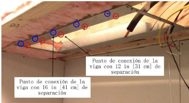
Las vigas del techo suelen instalarse con 12 in (31 cm) o 16 in (41 cm) de separación. Esto significa que el centro de las vigas de madera individuales se encuentra a una distancia constante de 12 in (31 cm) o de 16 in (41 cm) entre sí. La brida de montaje de acero galvanizado de la unidad Wine Guardian se ajustará cómodamente entre las vigas del techo con 12 in (31 cm) o 16 in (41 cm) de separación y le permitirá fijarla a cualquier disposición.
