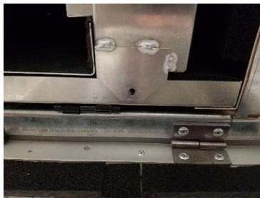
9. Reinstale la bandeja de condensado al volver a instalar el tubo de captación y al reconectar el cable de control.
