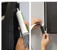
Selle la unión entre la cubierta EasyMount™ y el sistema Wine Guardian en el lado de la brida del sistema con una masilla de látex para asegurar un sellado hermético y evitar que el sistema se mueva horizontalmente. Después de sellar, añada el kit suministrado de tiras aislantes
