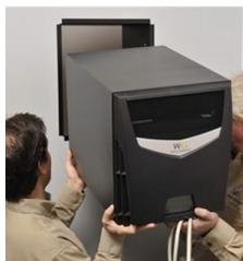
Deslice el sistema Wine Guardian *A Través de la Pared* por la cubierta EasyMount™ hasta la profundidad deseada. Por favor, tenga en cuenta que el sistema *A Través de la Pared* debe deslizarse de modo que el lado del cable de alimentación sea lo último, y no lo primero, a entrar en la cubierta. No deslice el sistema más allá del punto de montaje empotrado deseado.
